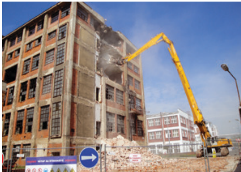
V létě roku 2012 proběhla významná demolice objektu Ry 14. Dnes se v tomto prostoru již zelená tráva.
