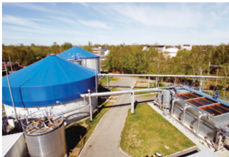
Celkový pohled na dokončený projekt
